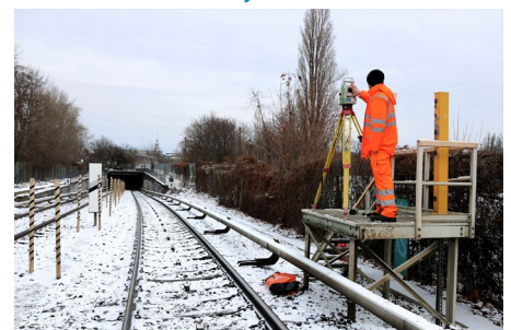
Festpunktmessung zum Bestandstunnel
