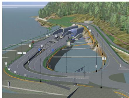
Mit den ersten Bohrungen für den Solbakk-Tunnel wurde im August 2013 begonnen. Mit einer Gesamtlänge von 14 km ist er der Haupttunnel des Projekts. Die beiden Röhren werden mittels Sprengvortrieb erstellt und sollen in einer maximalen Tiefe von 290 m unter dem Meer (Quelle: Statens vegvesen, 2013) verlaufen. Zum ersten Mal wurde dabei die neue innovative Software, Amberg Navigator, eingesetzt, mit der die Tunnel-Crew selbst die Arbeiten im Vortrieb steuern kann.
